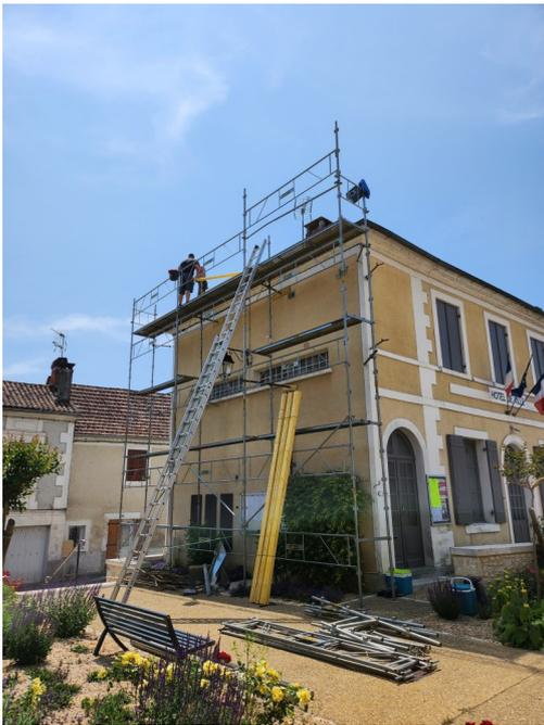
Les dommages causés par les intempéries et l'usure du temps ont affecté la toiture de la mairie, laissant l'eau s'infiltrer à l'intérieur. Il devenait urgent d'entreprendre des travaux de rénovation et d'isolation pour préserver l'intégrité du bâtiment et assurer un environnement sûr et sain pour le personnel et les visiteurs.
